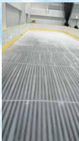
パイプが見えているリンク表面の写真
