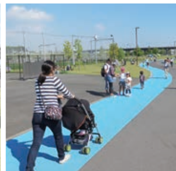
夏場の暑さ対策として、公園内園路の一部に施された遮熱塗装（青色部分）
